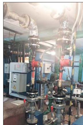
Для правильной циркуляции воды установили дополнительную трубу
